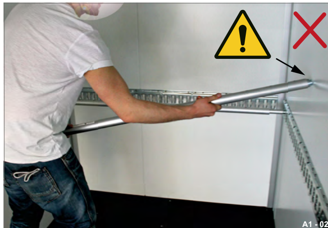
Abb. 160 Beschädigungsgefahr der Innenwände
